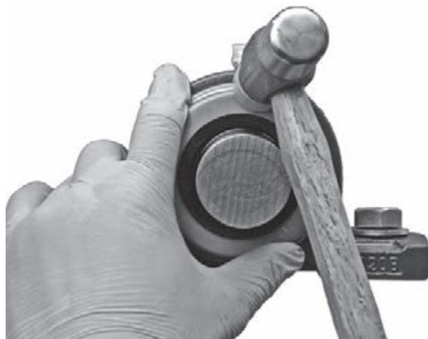
図 14.12 鋼板カバーの取付け
